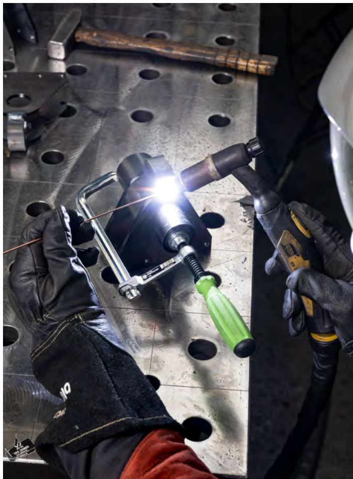
Durante i lavori di saldatura, il morsetto tutto acciaio funziona come una "terza mano". L'immagine mostra un modello della serie 469P.
