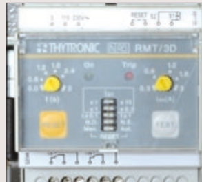
INTERRUTTORE DIFFERENZIALE EARTH FAULT BREAKER
