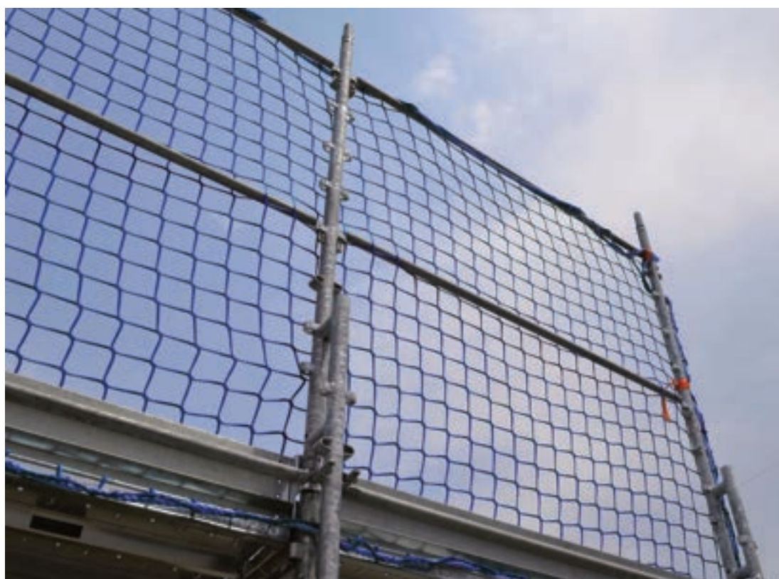
dettaglio anello di aggancio installato
