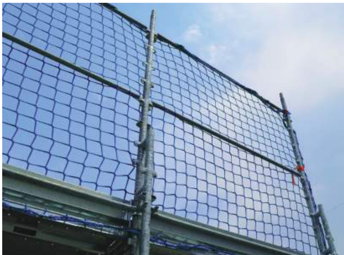
dettaglio anello di aggancio installato
