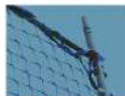
dettaglio anello di aggancio installato
